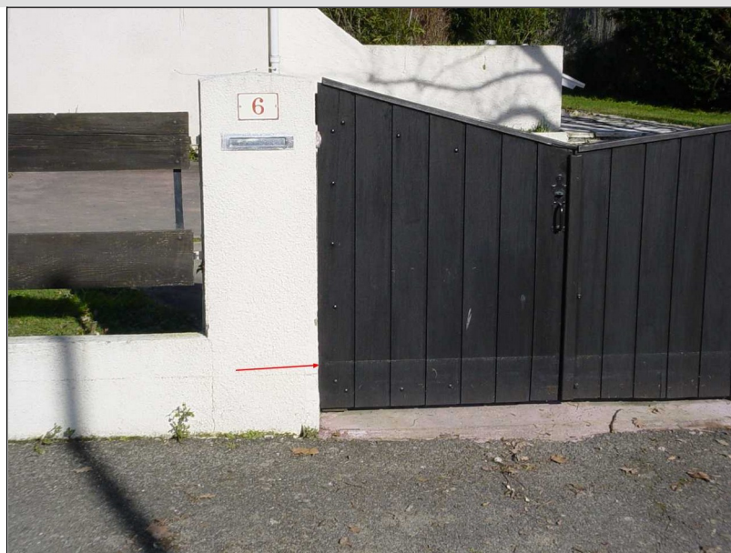
Photo n° 2 : Commune de Plaisance-du-Touch : la photographie montre les traces de la crue au niveau du n° 6 de la rue des Hortensias (environ 0,66 m).
