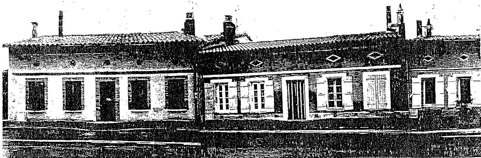
Bâti continu de maisons de type "toulousaine", rez-de-chaussé et combles ventilés, axialité et symétrie de la composition des façades autour de la porte d'entrée, encadrement et proportion des ouvertures, type de menuiseries, moulure et corniche...Trois des huit maisons contigües situées avenue des Pyrénées.
